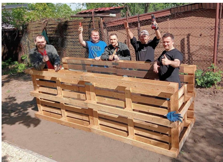
Wykonanie kompostownika do ogrodu społecznego.
