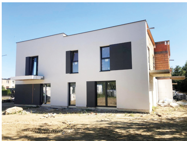
Budowa bloku wielorodzinnego przy ul. Piłskiej
