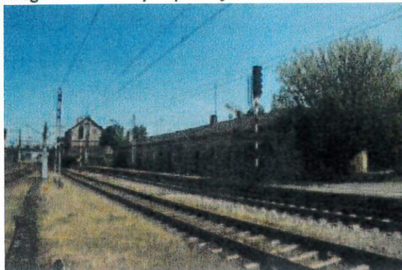
Zdegradowane budynki pokolejowe
