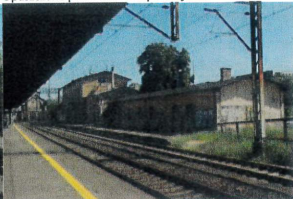
Opuszczone pomieszczenia pokolejowe
