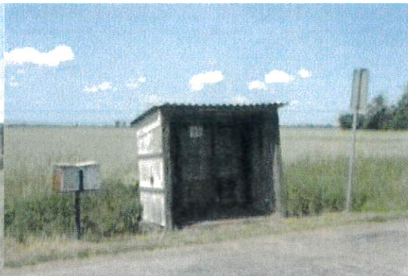
Zniszczony przystanek w drodze do Broniszewa
