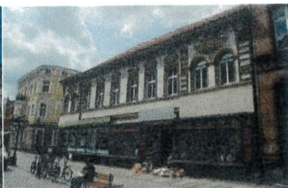
Atrakcyjna kamienica w rejonie ulicy Warszawskiej
