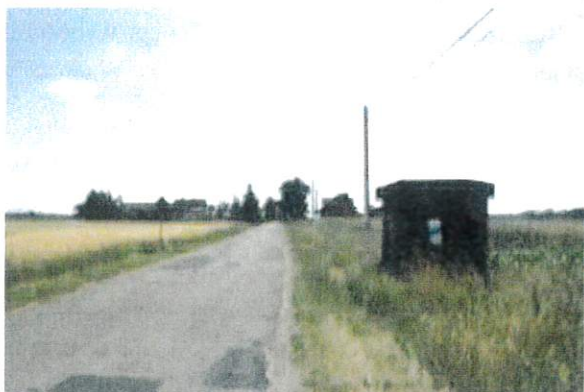
Nierówna nawierzchnia drogi prowadzącej do Noskowa
