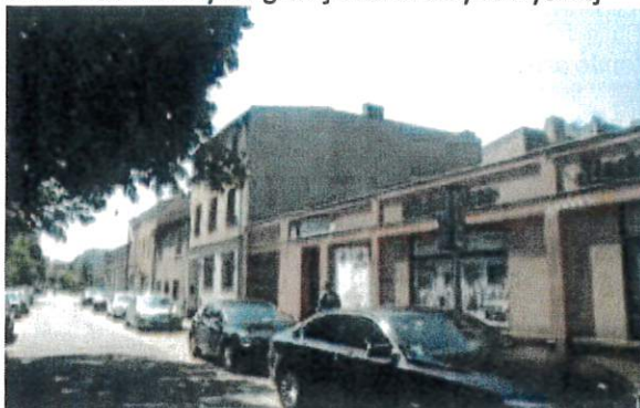
Stan infrastruktury drogowej wzdłuż ulicy Fabrycznej
