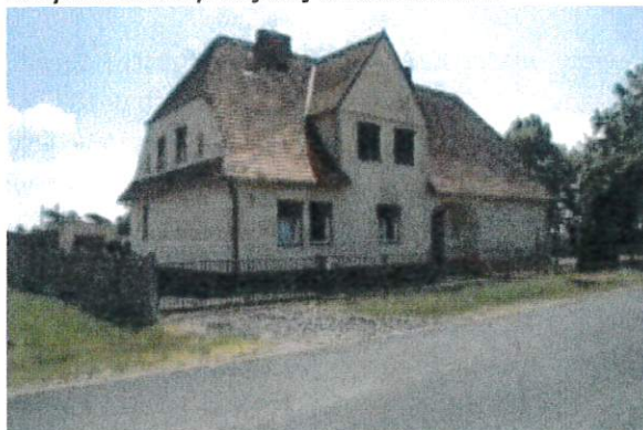
Budynek świetlicy wiejskiej w Stanisławowie
