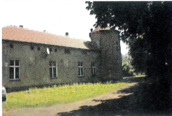
Widok na dwór w Gutowie Wielkim
