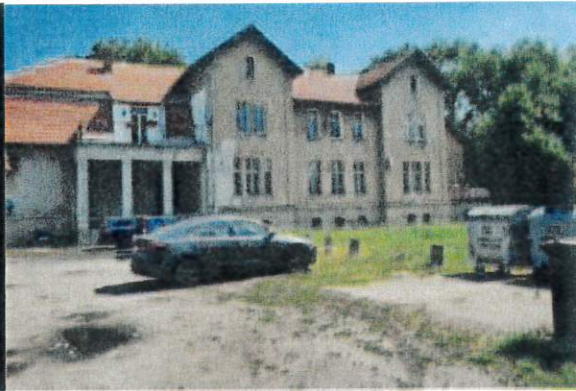
Widok na dwór w Gutowie Wielkim
