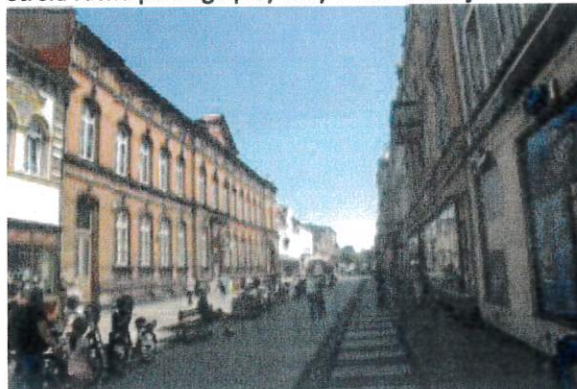
Strefa ruchu pieszego przy ulicy Warszawskiej
