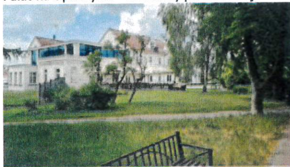
Pałac na Opieszynie – od strony południowej
