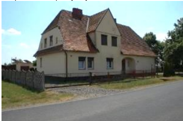
Budynek świetlicy wiejskiej w Stanisławowie
