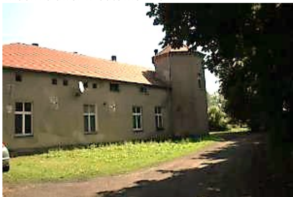
Widok na dwór w Gutowie Wielkim
