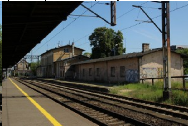
Opuszczone pomieszczenia pokolejowe
