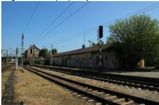
Zdegradowane budynki pokolejowe
