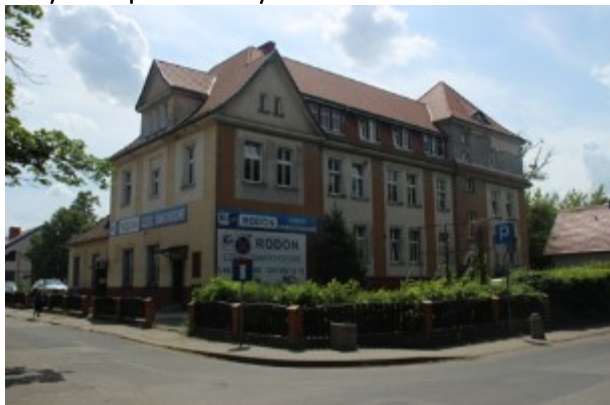
Przykład umiejscowienia podmiotów gospodarczych w budynkach pokoszarowych
