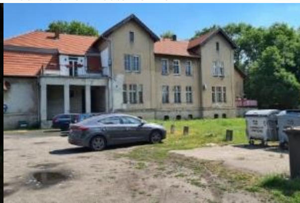
Widok na dwór w Gutowie Wielkim
